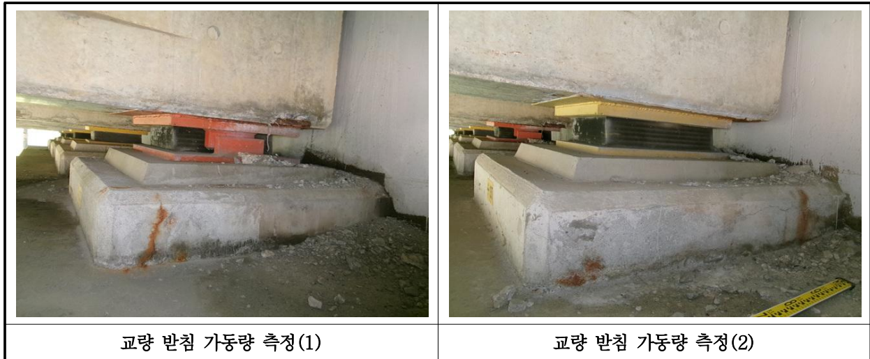
【사진 1.3.17】 교량받침 이동량 측정
