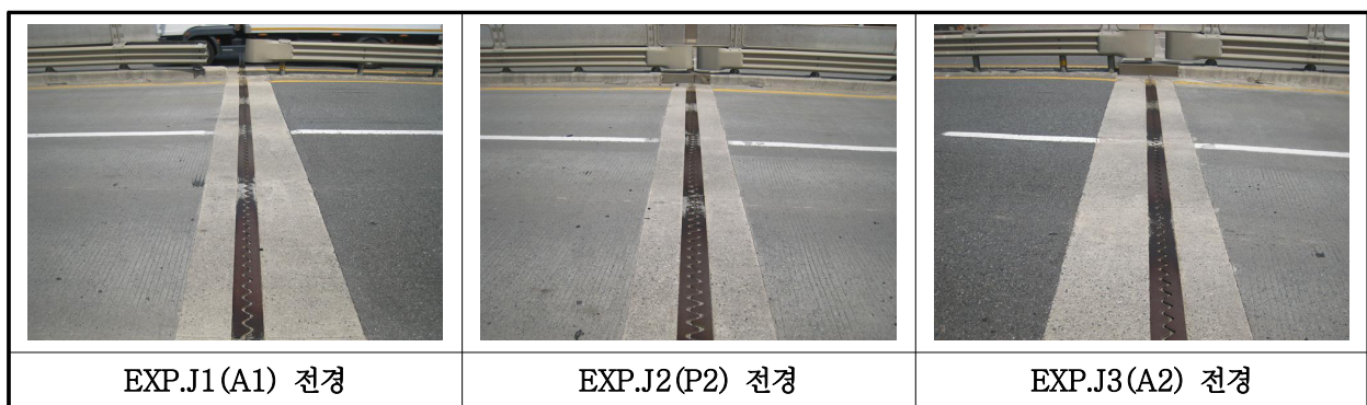
【사진 1.3.18】 신축이음장치 전경
