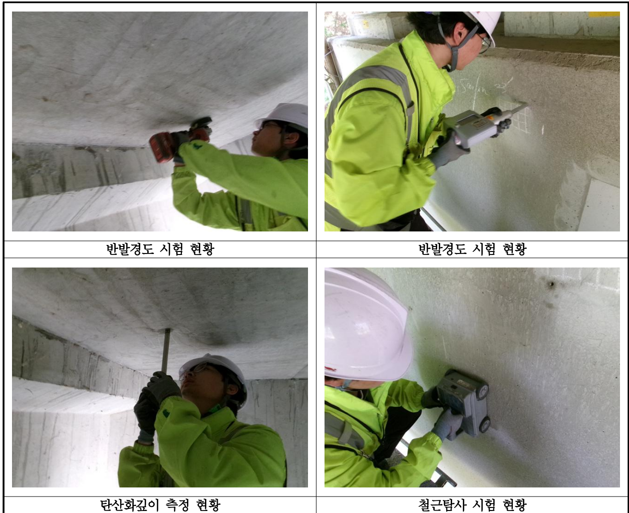
【사진 1.4.1】 콘크리트 내구성조사 현황
