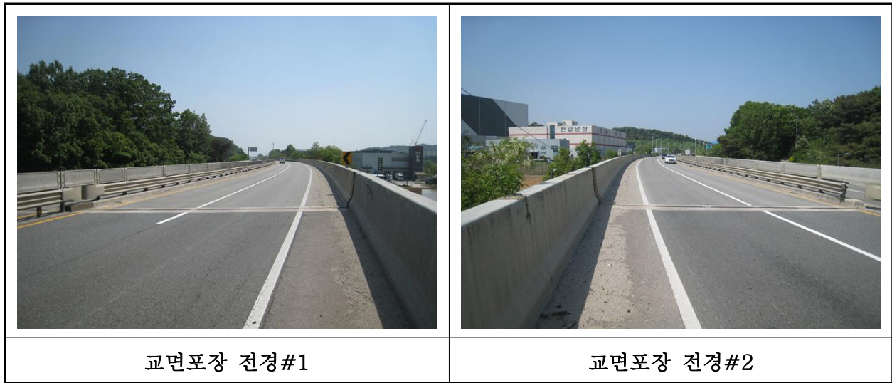
【사진 1.3.21】 교면포장 전경
