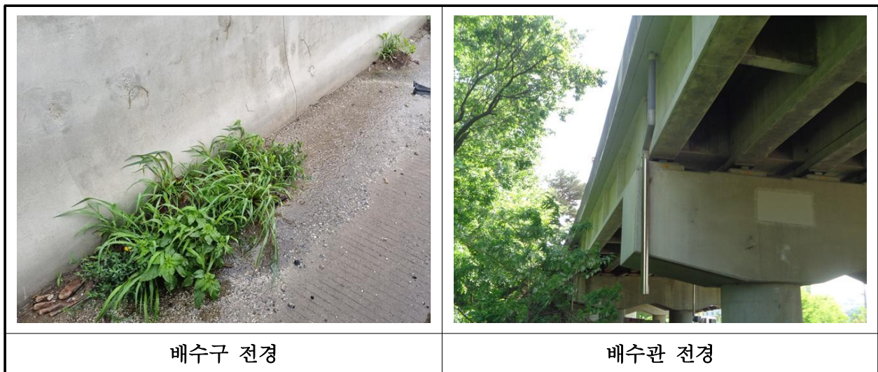
【사진 1.3.23】 배수시설 전경
