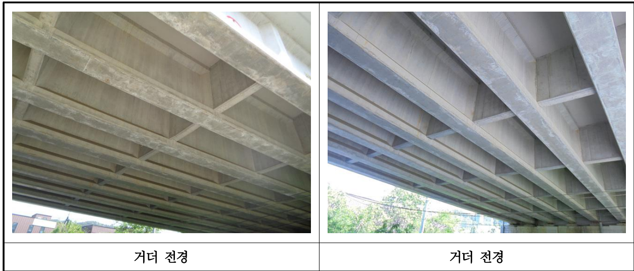
【사진 1.3.4】 거더 전경
