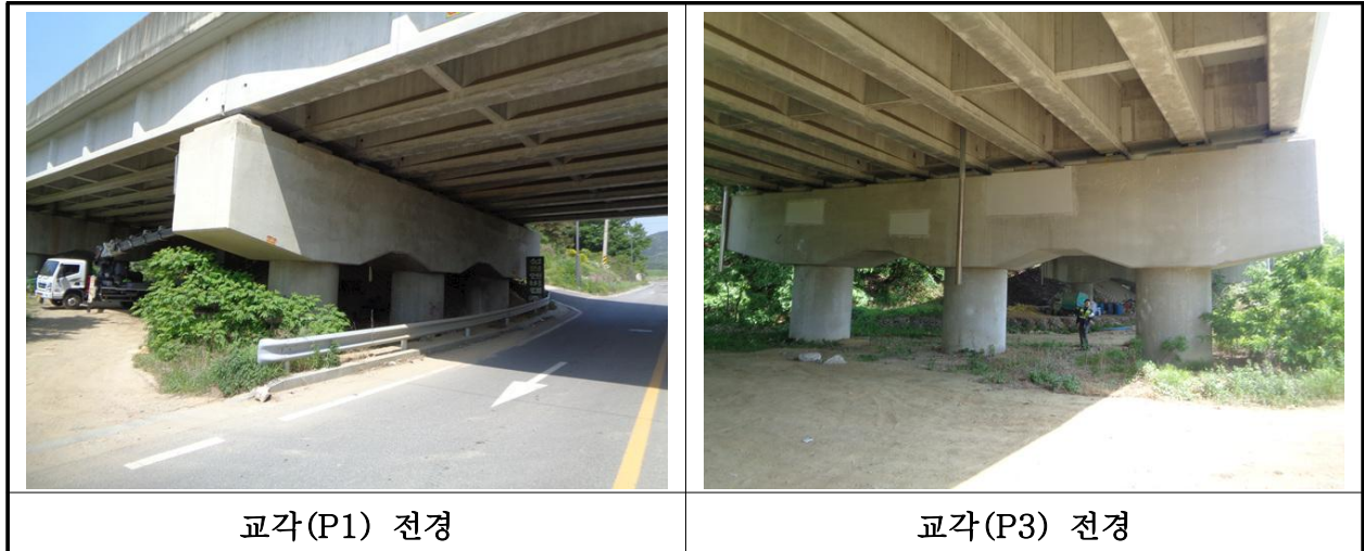
【사진 1.3.10】 교각 전경
