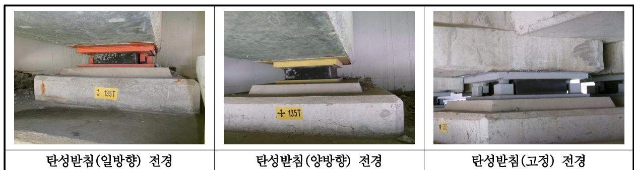
【사진 1.3.14】 교량받침 전경
