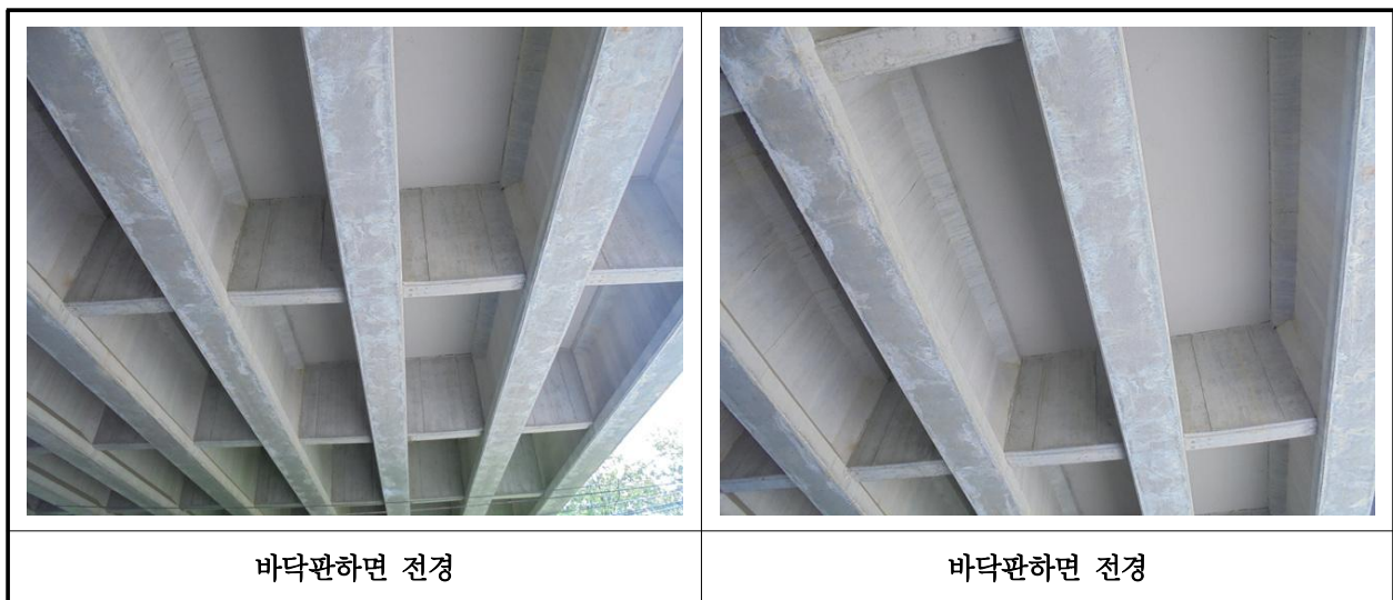
【사진 1.3.2】 바닥판하면 전경
