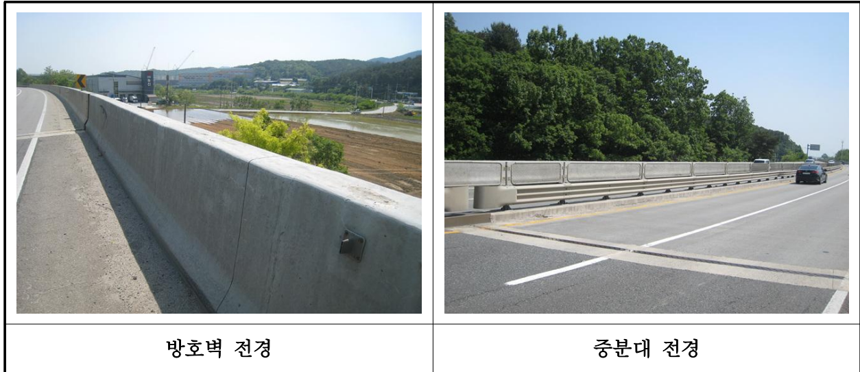
【사진 1.3.25】 방호벽 및 중앙분리대 전경
